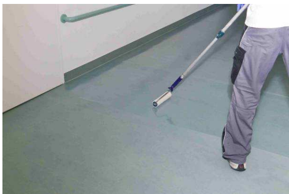
Bild 3: Nach der Grundreinigung wird der 2-Komponenten-Versiegelungslack RZ Turbo Protect Plus aufgetragen, der für extremen Langzeitschutz sorgt. Er ist besonders leicht zu verarbeiten und pflegeleicht.
